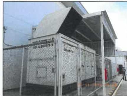
รูปที่ 2-54 เครื่องผลิตกระแสไฟฟ้าสำรองขนาด 600 kVA สำหรับโครงการโรงงานผลิตเส้นลวดทองแดง ที่มีออกซิเจน
