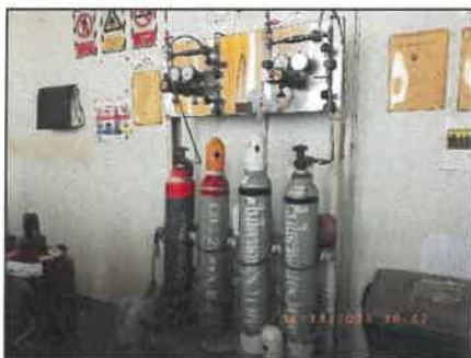
รูปที่ 2-5 ก๊าซสำรองสำหรับเครื่องตรวจวัดก๊าซ คาร์บอนมอนอกไซด์
