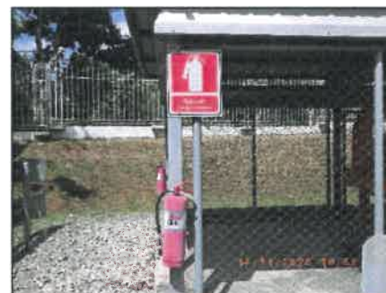
รูปที่ 2-48 เครื่องดับเพลิงชนิดผง (Powder Extinguisher)
